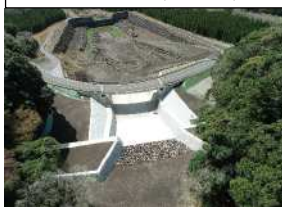
②荒瀬谷導流工(R5.3完成)
