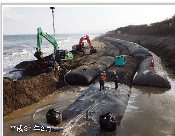
サンドバックの充填作業(住吉海岸)
