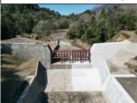
③丸谷第3砂防堰堤(R6.3完成)
