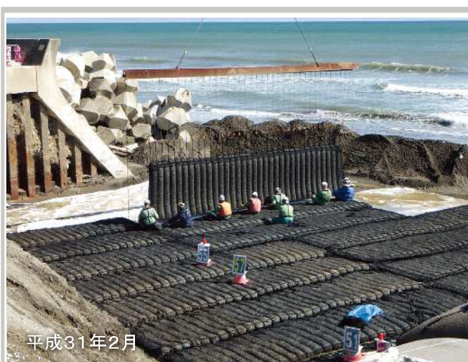
洗掘対策の施工(住吉海岸)
