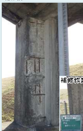
樋管補修の実施事例
