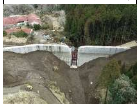
①皇子川1第3砂防堰堤(R4.3完成)
