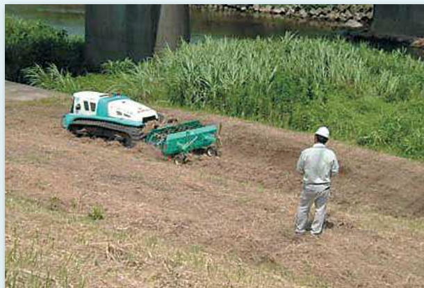
機械を使用した除草工事
